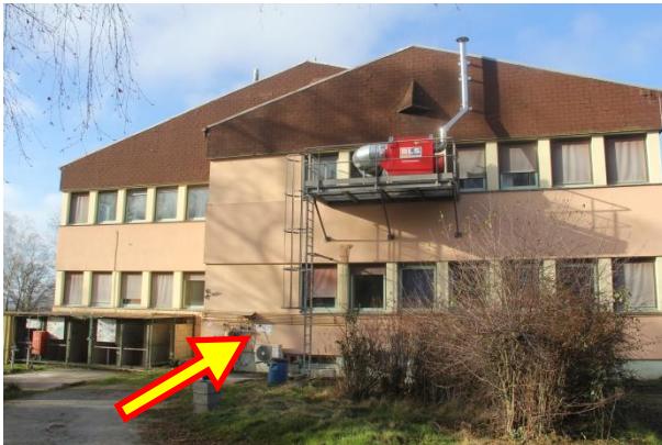
Photo : Face Est-1 du bâtiment
