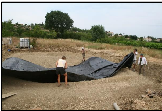
Pose de la bâche
