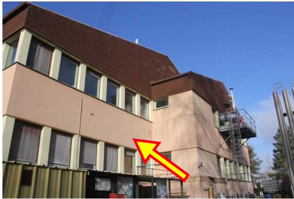
Photo : Face Est-2 du bâtiment
