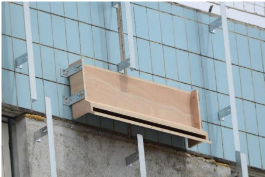
Photo : Gîte artificiel entouré d'isolant avec un bardage incomplet à l'IUT de Bourges (Arthur & Chrétien, 2020)
