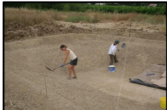
Nivellement manuel et pose de sable
