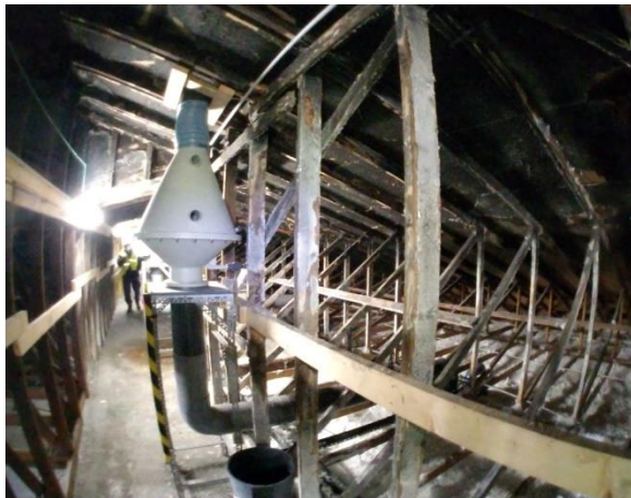
Photo : Vue d'ensemble du comble du bâtiment
