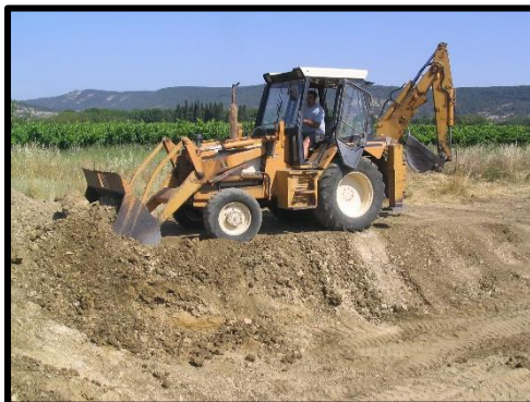
Creusement mécanique du bassin
